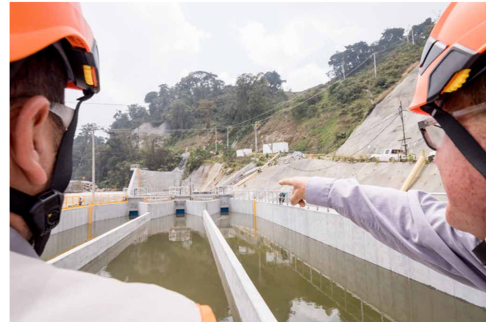
Central Hidroeléctrica San Andrés de Cuerquia Antioquia, Colombia
