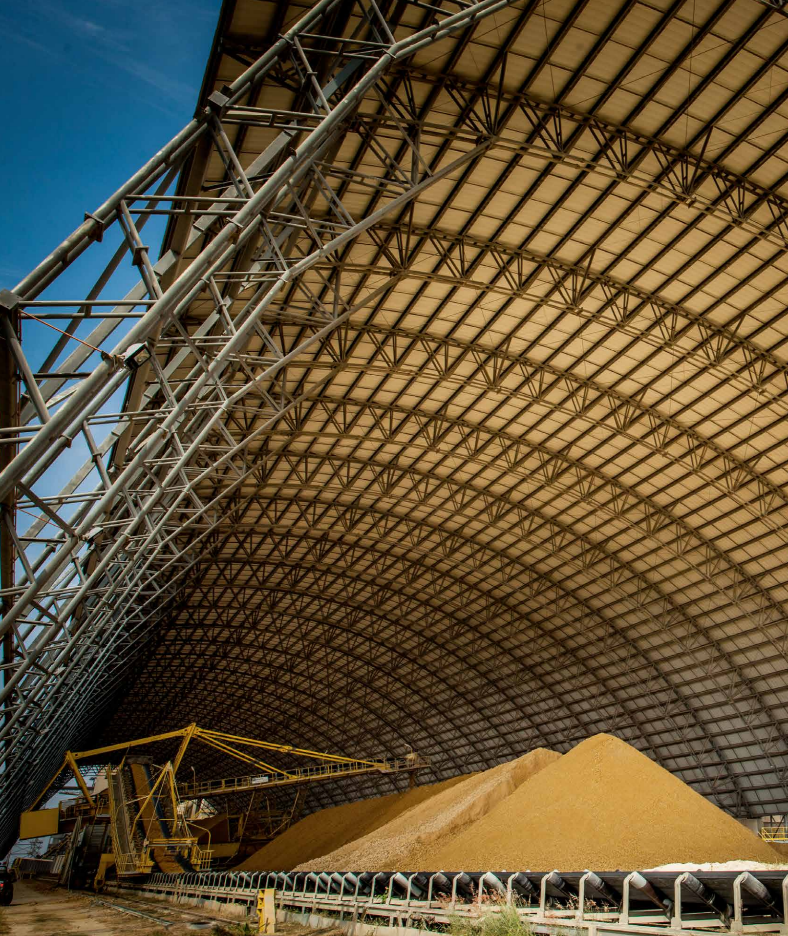
■ Patio de clínker, planta de Cementos Argos Cartagena, Colombia
